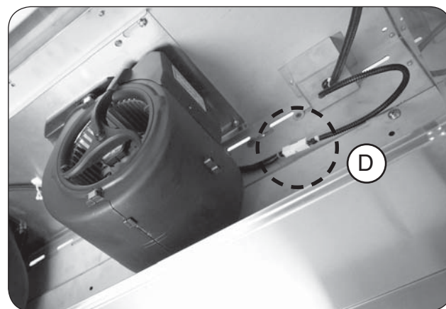
Fig. 16-3 Connect fan assembly wire
